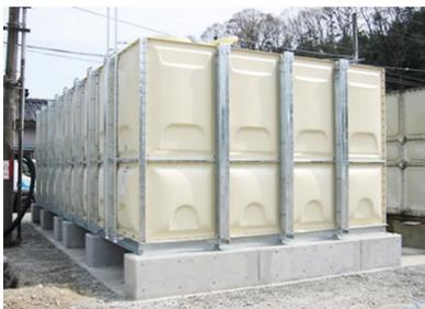
災害時に水を確保する貯水システム「貯得（ためとく）<sup>※3</sup>」
