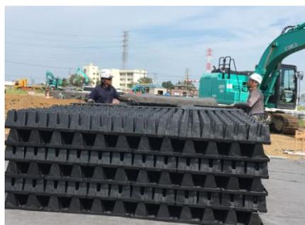
雨水貯留システム「クロスウェーブ」
