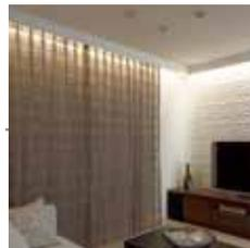
光を壁面に反射させる間接照明「LEDコーニス照明」はカーテンやブラインドのボックス仕様もできます。
