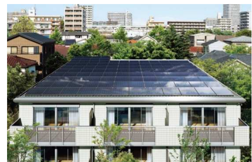
大容量 PV 搭載のフラット屋根
