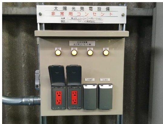
中四国セキスイハイム工業株式会社に 設置された非常用コンセント
