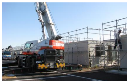
応急仮設住宅棟下の様子
